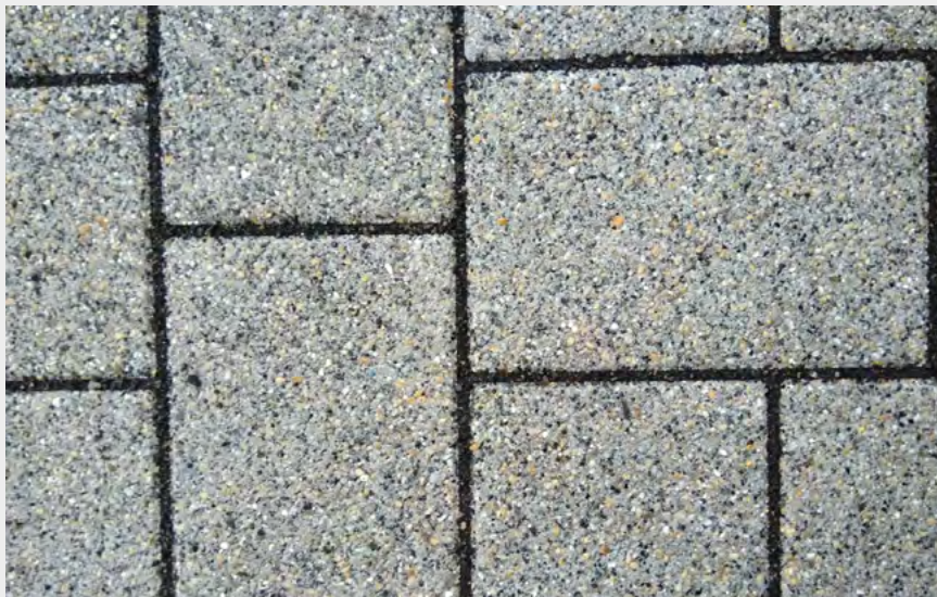
Einwandfreie Fugenfüllung mit dem Material ECOPREC®. Vor Abnahme der Maßnahme wurde die Fugendichte mit einer Fugensonde kontrolliert. (Bild: BERDING BETON GmbH)
