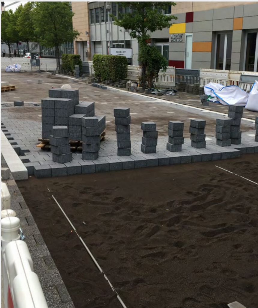
...auf einer Bettung von 3 cm ECOPREC® wurden die neuen Pflastersteine verlegt...
