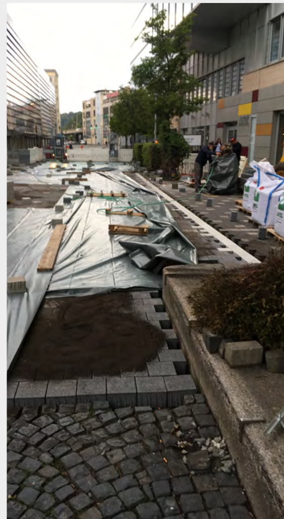
...das Material ECOPREC® dient auch als Fugenmaterial. (Bilder: Stadt Siegen)
