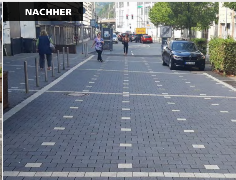
Cheops Pflastersteine in Kombination mit dem ECOPREC® Bauverfahren waren eine gute und zeitsparende Lösung für die Sanierung der Siegener Fußgängerzone. (Bild: Stadt Siegen)
