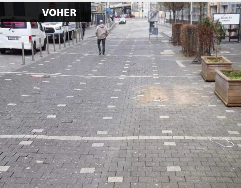
Spurrinnen prägen das Bild auf der Morleystraße in Siegen. (Bild: Stadt Siegen)
