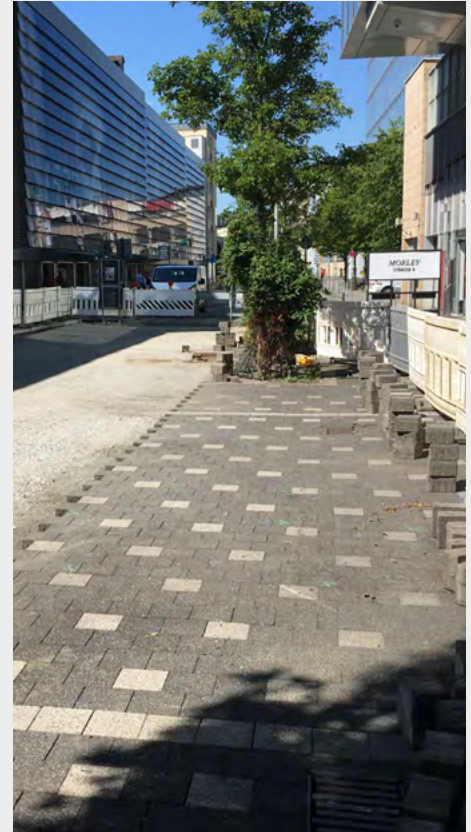
...die Tragschicht ein wenig nachverdichtet... (Bilder: Stadt Siegen)
