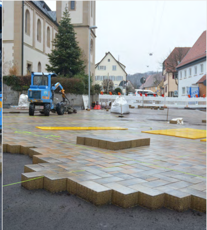
Verlegt wurde das VS5-Pflaster auf eine ECOPREC®-Bettung. (Bild: SF-Kooperation GmbH Beton-Konzepte)
