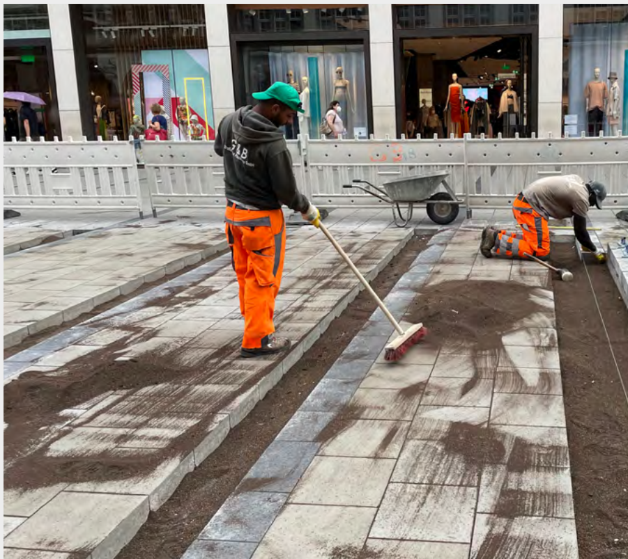
Das bituminöse Material ECOPREC® sorgt für eine dauerhaft stabile Fuge. Die üblichen Probleme, die man von Pflasterflächen kennt, bei denen sich Fugenmaterial auswäscht und es dann zu Schäden kommt, sind hier daher kein Thema. (Bild: SF-Kooperation GmbH Beton-Konzepte)
