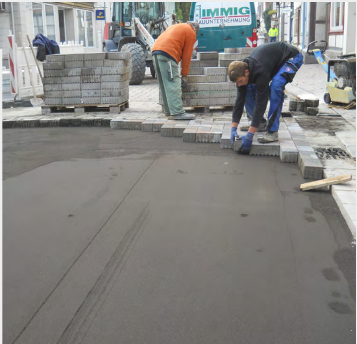
Verlegung der VS 5-Pflastersteine auf das ECOPREC®-Bettungsmaterial. (Bild: SF-Kooperation GmbH Beton-Konzepte)
