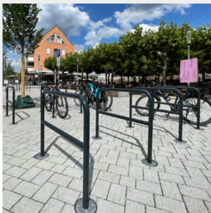
oben: Auch die Diagonalverlegung bringt Stabilität für die Albstraße.
