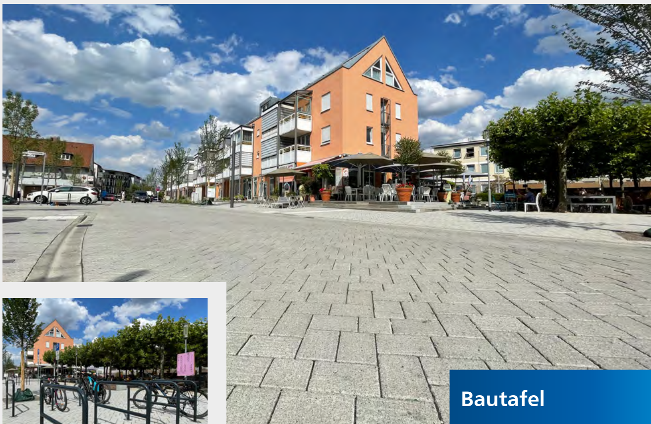
oben: Auch die Diagonalverlegung bringt Stabilität für die Albstraße.
